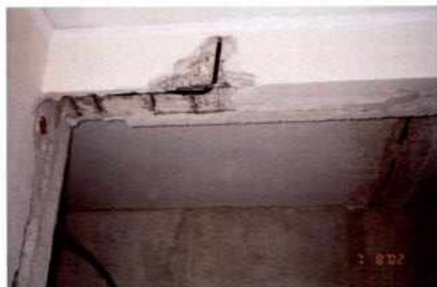
Distruzione della sezione di una trave in cemento armato per l'inserimento di cavidotti
