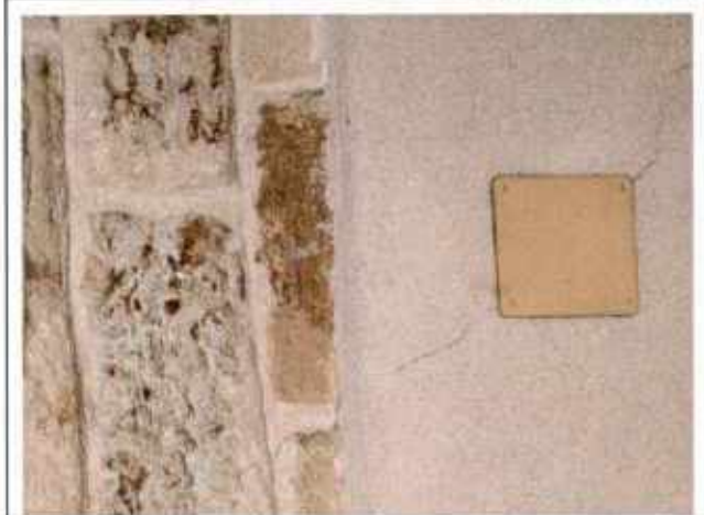
Cassette impiantistiche inserite all'interno di pareti interne
