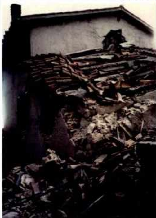
Sostituzione copertura a tetto che ha appesantito il fabbricato
