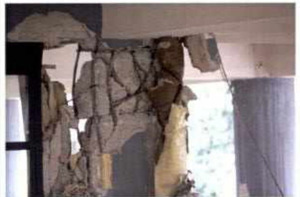
Piani porticati ed aggravamento del danno a causa di aumentata vulnerabilità sismica da "piano soffice"
