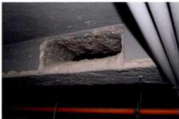
Bucature travi in cemento armato per passaggio canali climatizzazione
