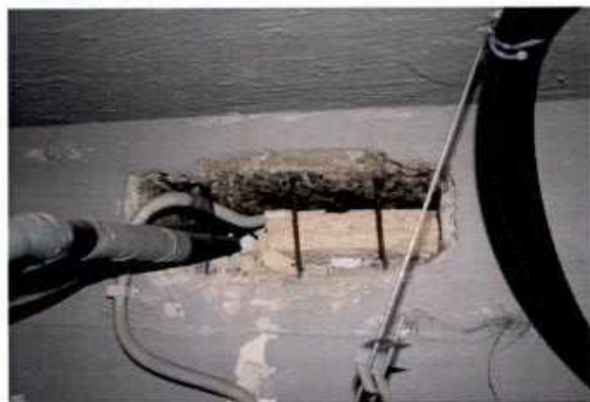
Bucatura cordolo in cemento armato per passaggio condotte impiantistiche
