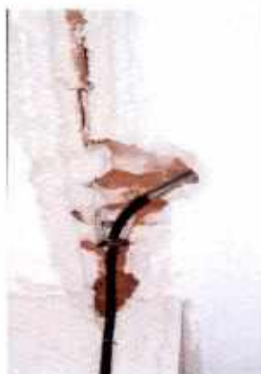
Danneggiamento travetto solaio per passaggio cavidotto
