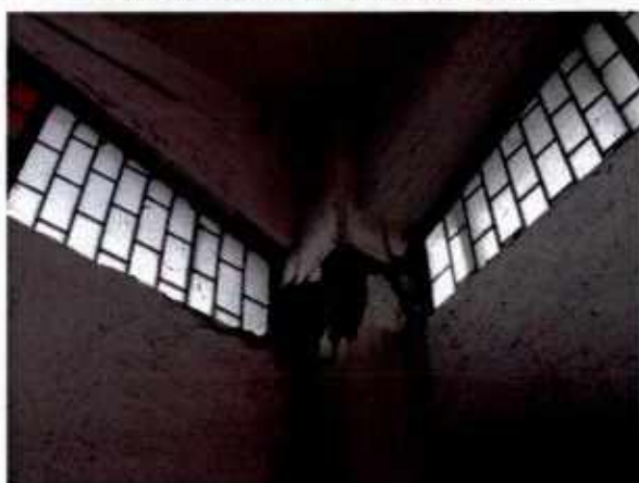
Finestre a nastro e danno a pilastro
