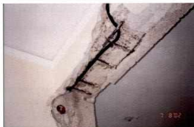
Bucatura pilastro per inserimento cassetta
