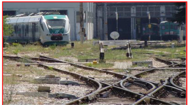
Figura 6 Binari su massciata ferroviaria
