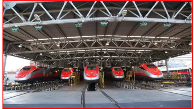
Figura 2 Binari sopraelevati su colonnine
